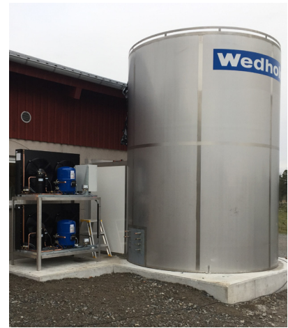
Silo med kylaggregat och alkov under installation.
